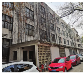
图 1 改造前实景照片
