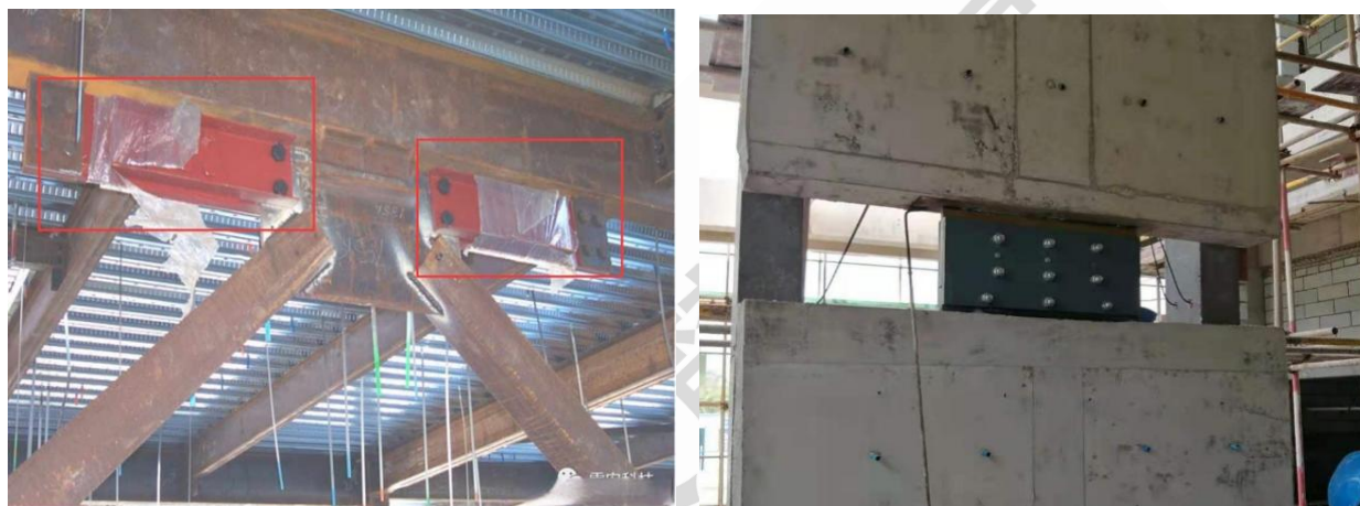
图 3 摩擦阻尼器连接图
